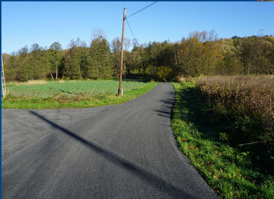
ul. Zielona po remoncie
