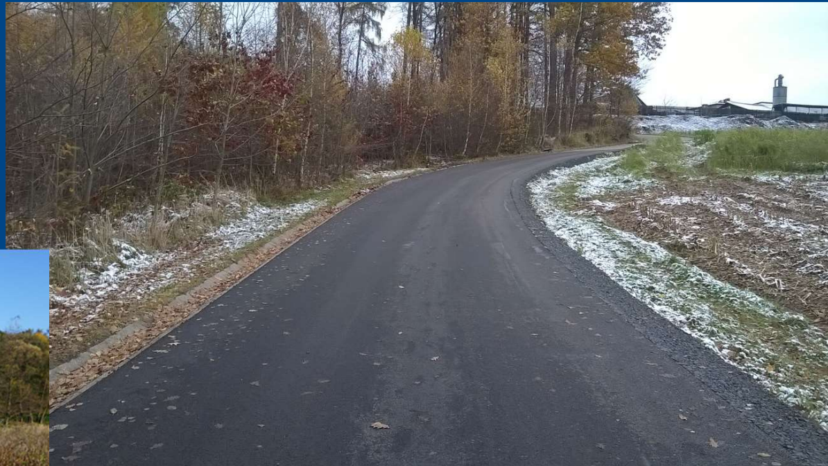
ul. Brzezińska po remoncie
